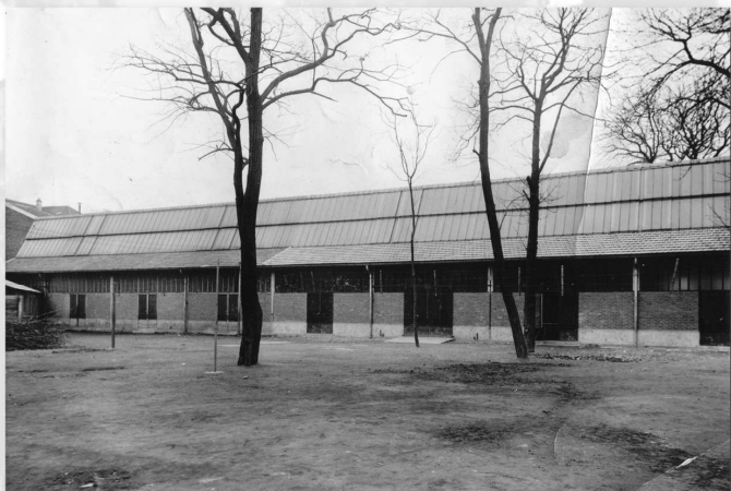
Le nouveau bâtiment complet, la surface est doublée, 1000 m 2 d'atelier pour 90 élèves du technique. Ce bâtiment gardera cet aspect jusqu'en 1971.
