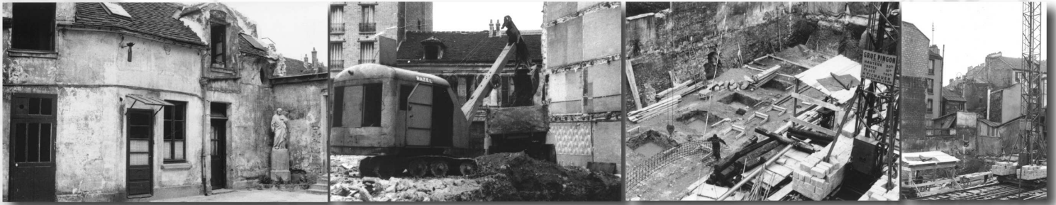
L'ancienne conciergerie et les maisons portant les N°5 et 5 bis de la rue des Ursulines datant de l'époque où Jean-Baptiste de La Salle créa en 1709 la première école de maîtres, sont détruites pendant l'été 1955. Les travaux sont finis à temps pour la rentrée d'octobre 1956.
